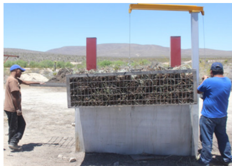
Canastilla con planta y grúa de carga al equipo
